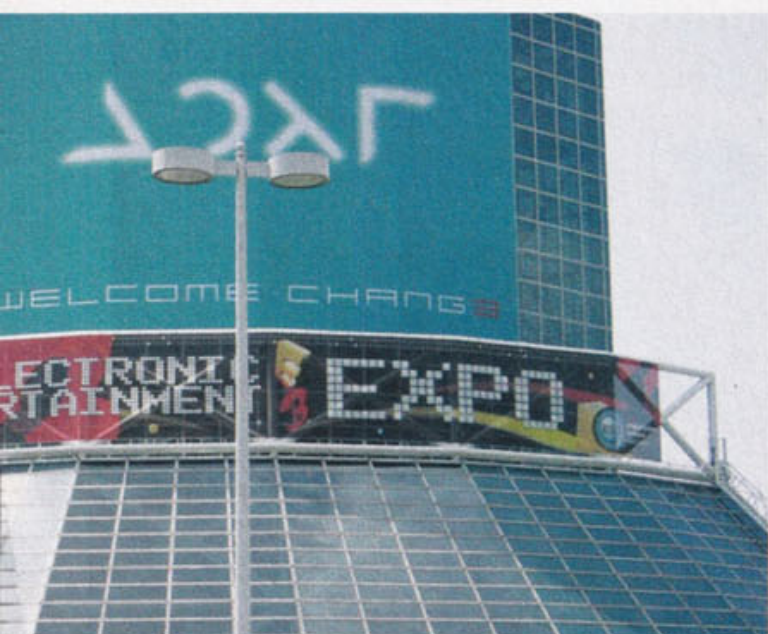
▲ A fachada do edifício chama a atenção dos visitantes. Destaque para os botões do PlayStation
